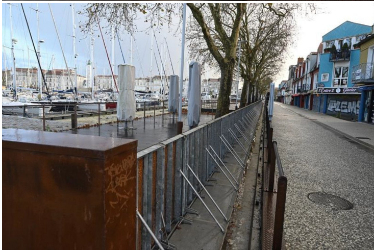
5 Système de plaques relevables
